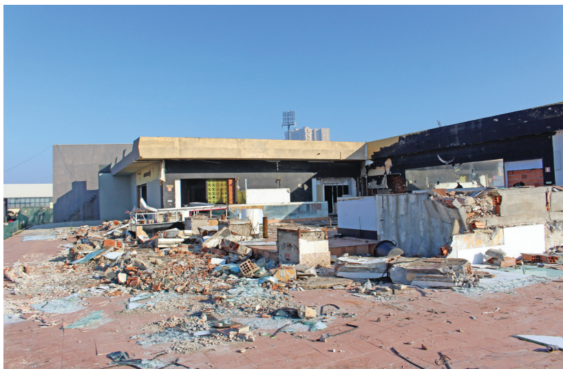
Demolição do Maresia
